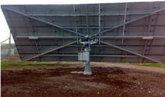
Rückseite eines Nachführsystemes mit 42 Modulen von SANYO
