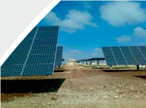
Nachführsysteme im Testbetrieb und Wartungsmodus (rechts hinten)
